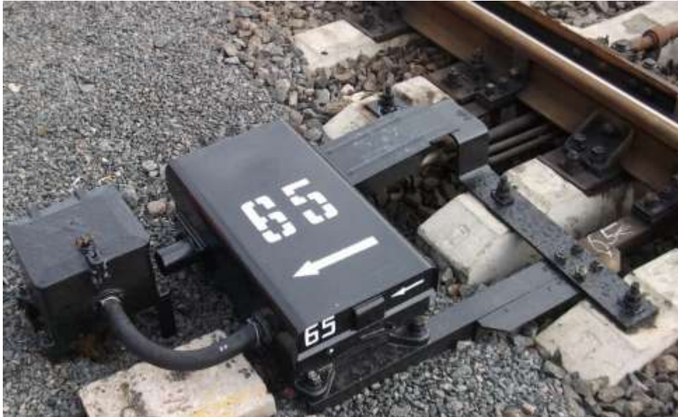
Рисунок 5.8 – Обозначение нормального положения стрелочного перевода на кожухе электропривода
