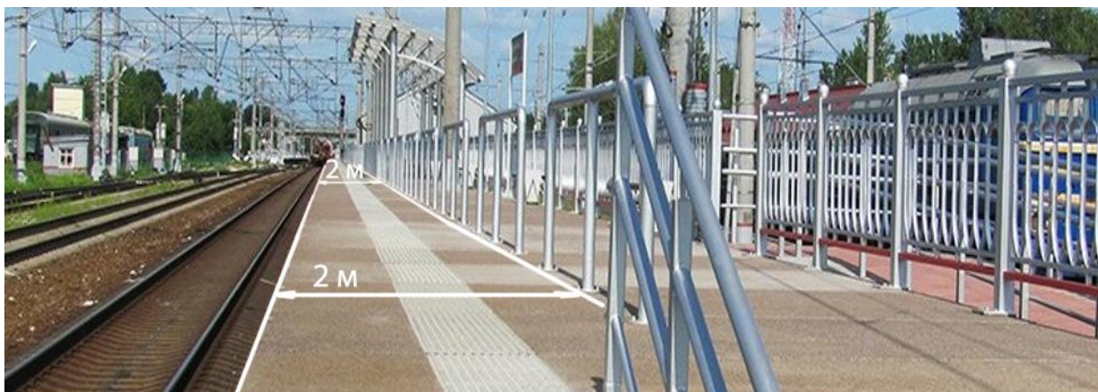
Рисунок 2.8 – Пример ограждения пассажирской платформы на высокоскоростной линии
